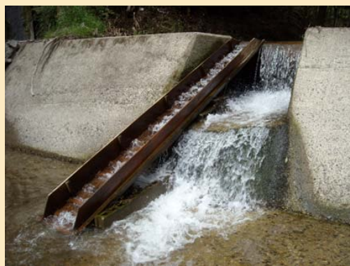
＜オオサンショウウオが体を寄せる壁を設けた改良型の斜路＞
