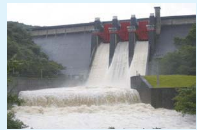
洪水調節中の室生ダム
