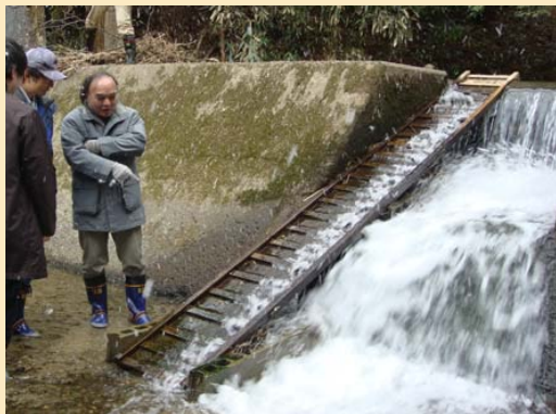
＜学識者による自然河川に設置した斜路に対する現地指導＞
